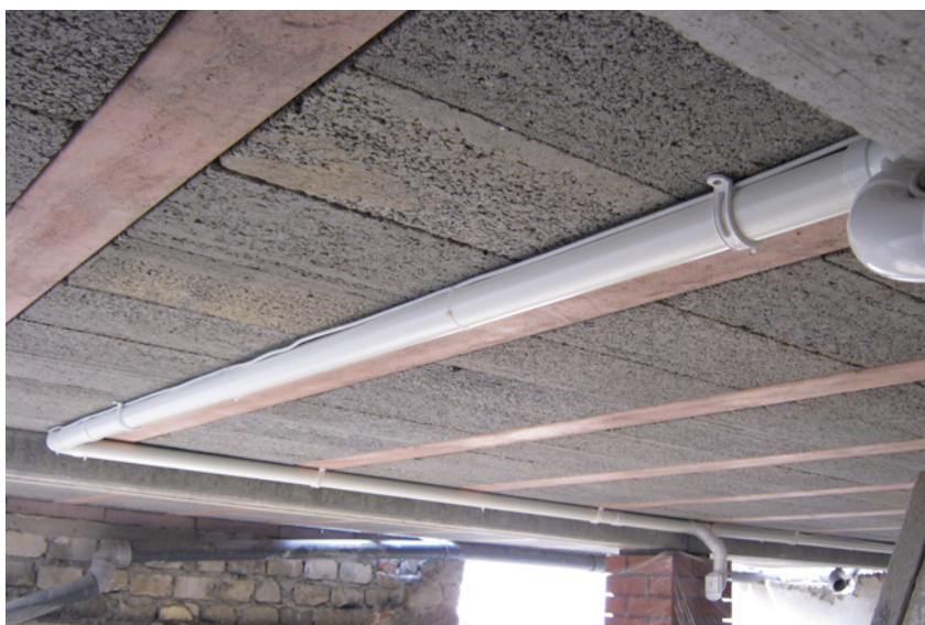
◀ ▲ Rurociąg najłatwiej rozprowadzić na etapie stanu surowego. Orurowanie można poprowadzić w podłodze, na ścianach, ale też na stropie i zamaskować podwieszanym sufitem. TOPVAC
