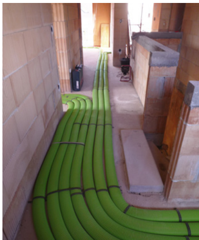
▲ Tylko w nowym domu możemy ukryć kanały w grubości podłogi lub w stropie. W tych już użytkowanych to właśnie problem z ułożeniem kanałów okazuje się zwykle najpoważniejszy. WOLF
