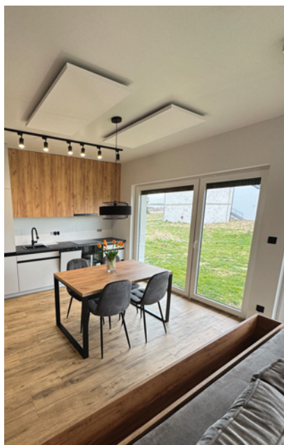
▲ Promienniki zawieszane pod sufitem. Szczególnie w wysokich pomieszczeniach nie warto ogrzewać powietrza. ECO PARTNER
