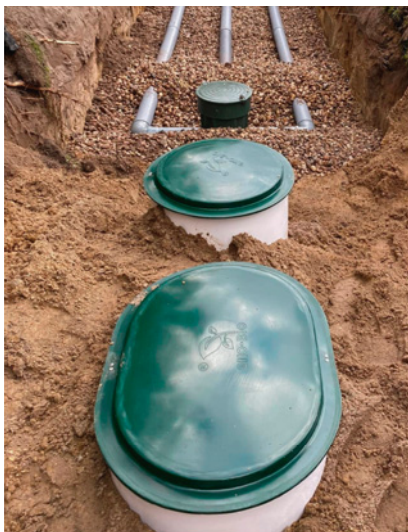
▲ Najważniejszym elementem oczyszczalni z drenażem jest system perforowanych rur, które układa się warstwie żwiru lub tłucznia. EKO-BIO OCZYSZCZALNIE
