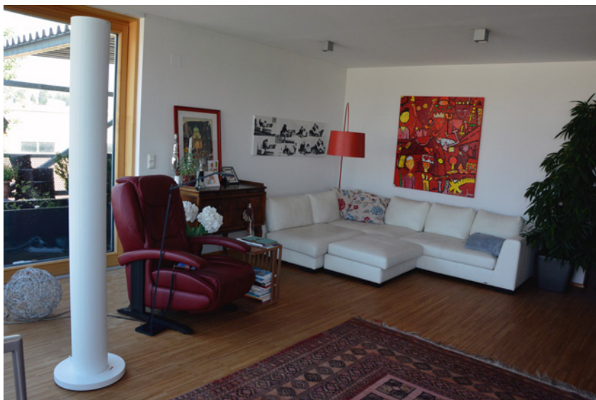
◀ ▶ Emiter podczerwieni może być też wolnostojącym grzejnikiem. REDWELL
