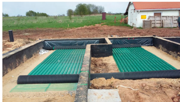
▲ GWC pozwala wykorzystywać darmowe ciepło zawarte w gruncie. Może być umieszczony również pod budynkiem. GLOBALTECH
