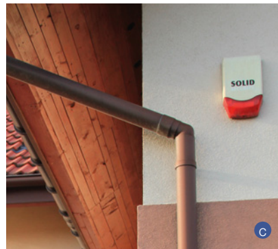
▲ Instalacja inteligentna składa się z sensorów i aktorów. Do tej pierwszej grupy należą m.in. rozmaite czujniki ( a YALE) i klawiatury ( b SOMFY), a do drugiej np. syreny alarmowe ( c J. WERNER).
