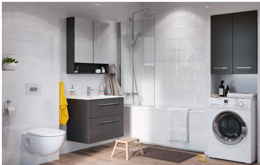
▲ Dzięki temu, że rury wodociągowe mają niewielką średnicę i można je ukryć w bruzdach ściennych, instalacja wodna jest praktycznie niewidoczna. GEBERIT
