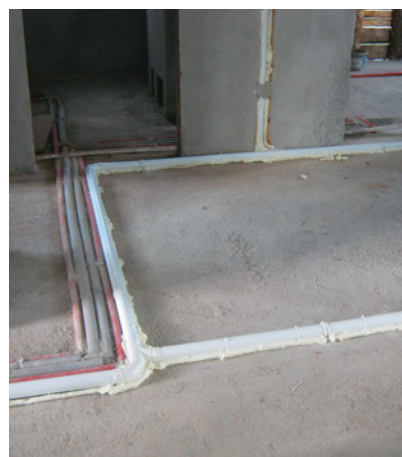
◀ ▲ Rurociąg najłatwiej rozprowadzić na etapie stanu surowego. Orurowanie można poprowadzić w podłodze, na ścianach, ale też na stropie i zamaskować podwieszanym sufitem. TOPVAC
