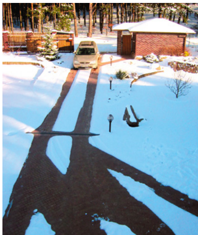
▲ Ogrzewanie przeciwołodziwowe świetnie sprawdza się w przypadku długiej drogi dojazdowej do garażu. FENIX POLSKA
