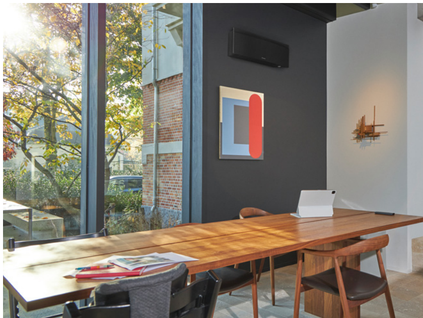
▲ To dobra automatyka powinna decydować, które urządzenie trzeba uruchomić. Czasem zamiast włączać klimatyzator, wystarczy zasłonić okno roletą lub markizą. DAIKIN
