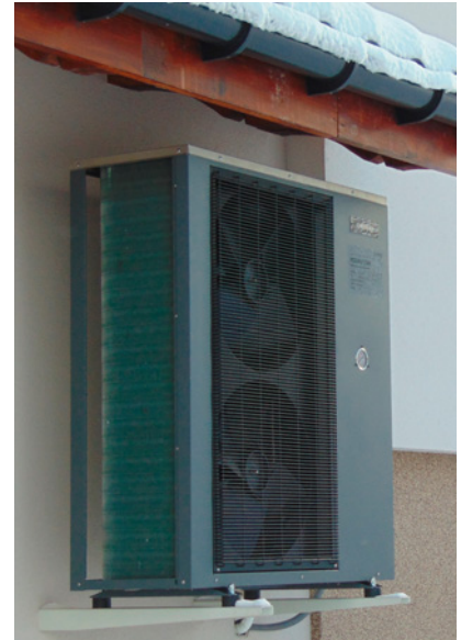
▲ Moc większości pomp powietrznych bardzo wyraźnie się obniża wraz ze spadkiem temperatury zewnętrznej. Ten sam model może mieć np. 10 kW przy +7°C, ale tylko 5 kW przy -15°C. HEWALEX
