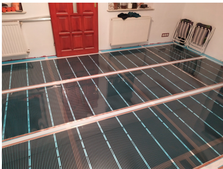
▲ Folie grzewcze sprzedawane są na rolki, metry i w kompletnych zestawach montażowych. Można je stosować również na ścianach i sufitach. TERMO-FOL
