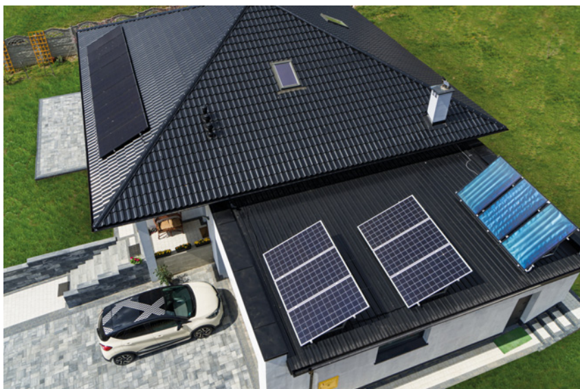
▲ Płaski dach garażu bardzo dobrze nadaje się do ustawienia na nim paneli na stelażu nośnym. Wówczas można wybrać najlepszy kąt ich nachylenia. BRUK-BET FOTOWOLTAIKA
