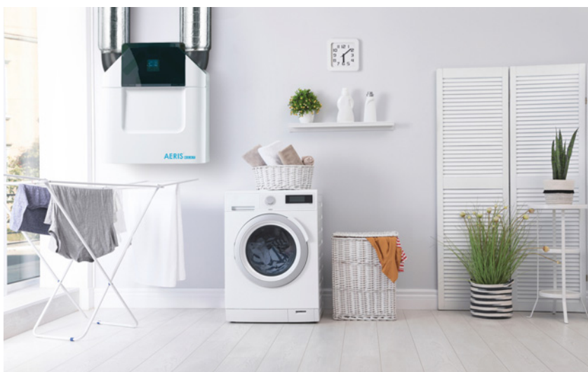
▲ Wentylacja z rekuperatorem zapewnia nie tylko oszczędność energii, ale przede wszystkim skuteczną wymianę powietrza we wszystkich pomieszczeniach i przez cały rok. To oznacza zaś zdrowy mikroklimat dla domowników. ROHA/REKUPERATORY.PL
