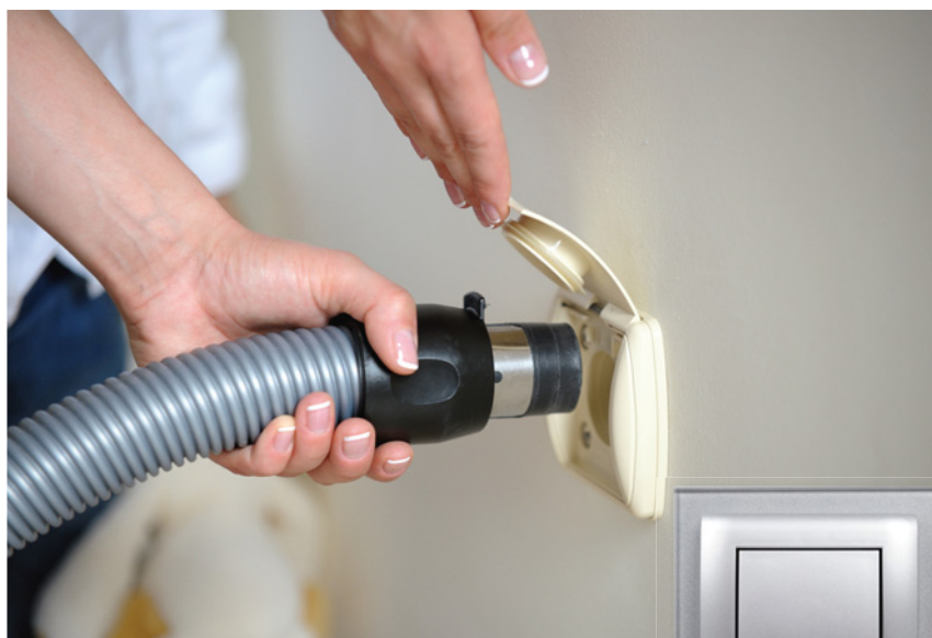
► Do sprzątania używa się jedynie elastycznego węża z odpowiednią końcówką. W większości systemów po wetknięciu węża do gniazda ściennego instalacja zaczyna pracować. USTM
