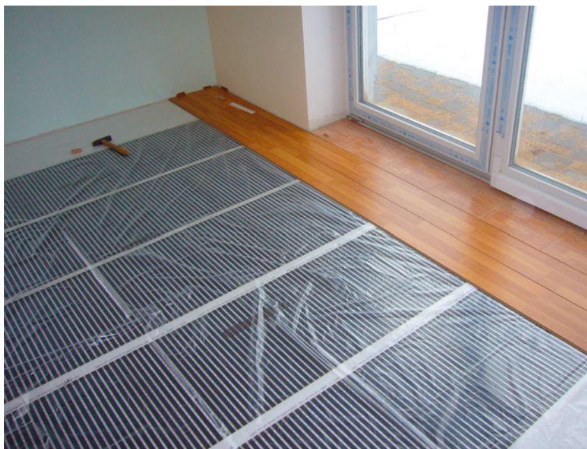
▲ Folie grzejne można rozkładać bezpośrednio pod drewnianymi lub laminowanymi panelami. Ich grubość to zaledwie 0,2–0,3 mm. FENIX POLSKA
