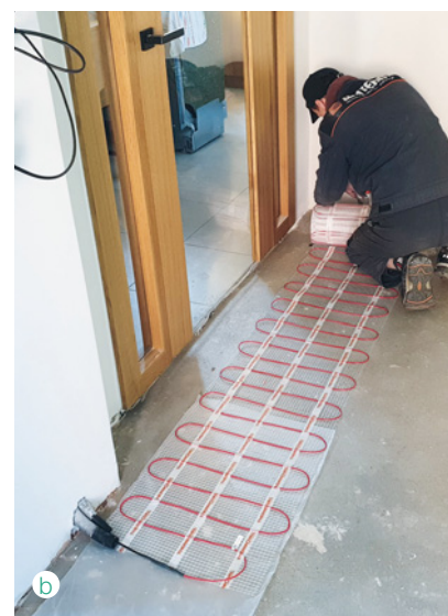
◀ ▲ Układanie przewodów grzejnych (a DEVI/DANFOSS) i mat grzewczej (b THERMOVAL).
