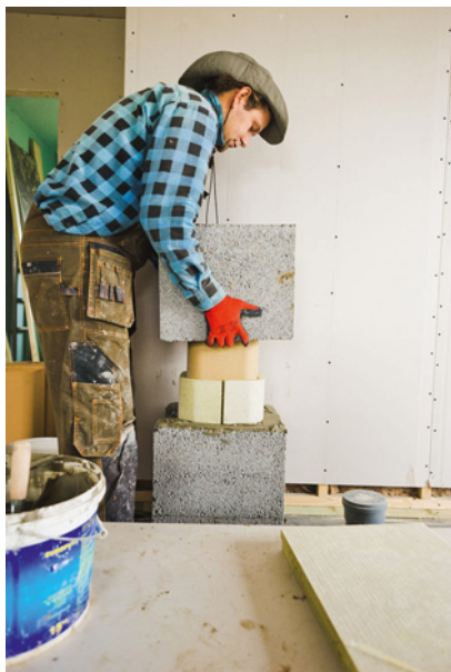
▲ Jedną z największych zalet kominów systemowych jest łatwość montażu. PLEWA
